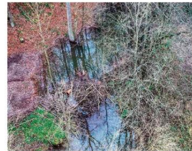
Dieser Biberdamm, wo die Nager ihre Burg haben, sorgt für Überschwemmungen im Bereich des Grundstückes Räder. Zu erkennen die Drainageröhre, über die Wasser abfließen soll, um eine Überschwemmung der Grundstücke zu verhindern. Foto: Andy Schöneberg
